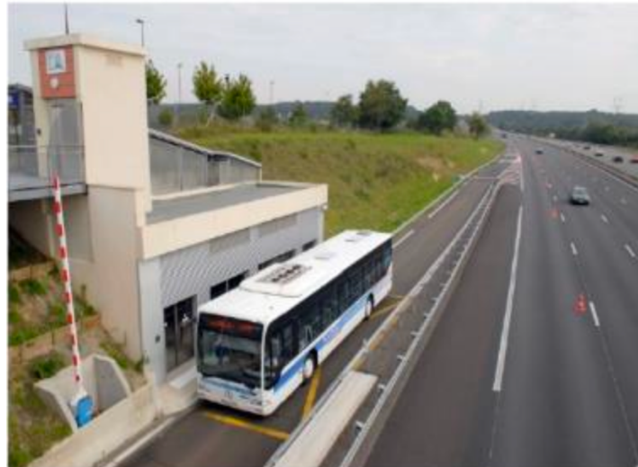
Abbildung 21: Darstellung einer möglichen Ausgestaltung einer Haltestellenbucht mit einem sicheren Bussteig an einer Autobahn
